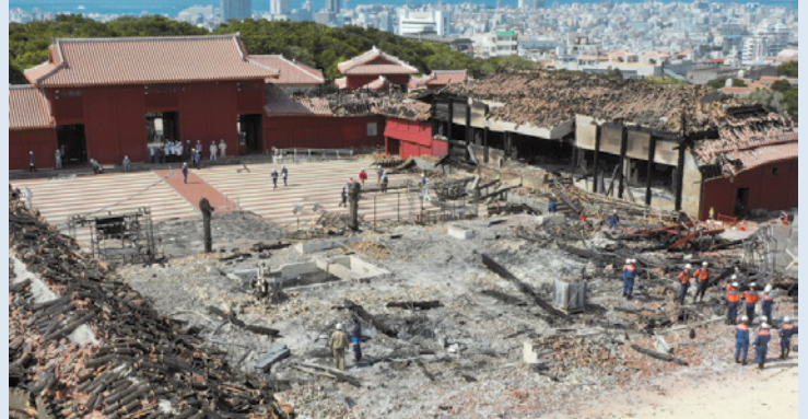
首里城火災（沖縄県）令和元年10月31日
